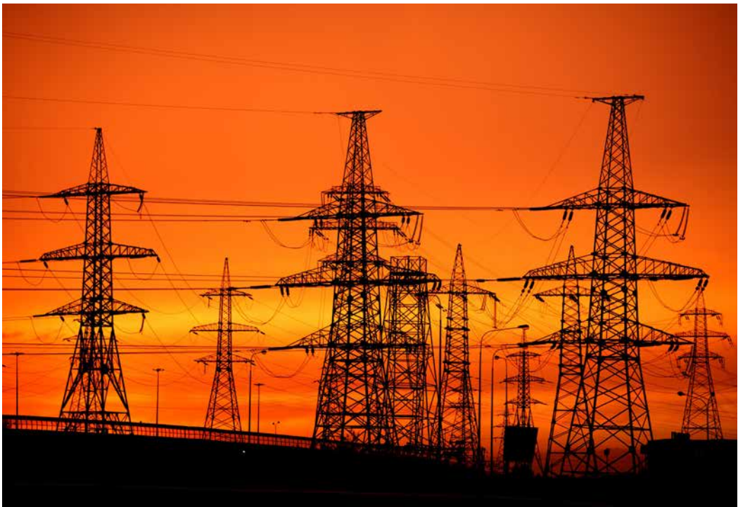
Afb. 7 Hoogspanningsmasten met hoogspanningskabels. (Bron: 123RF)
